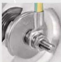
Priključak uzemljenja nakon skidanja ploče za oplatu
