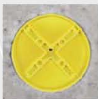
Ploča za oplatu nakon betoniranja
